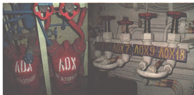
Рисунок 3 – Размещение элементов системы пожаротушения ЛОХ на подлодках
